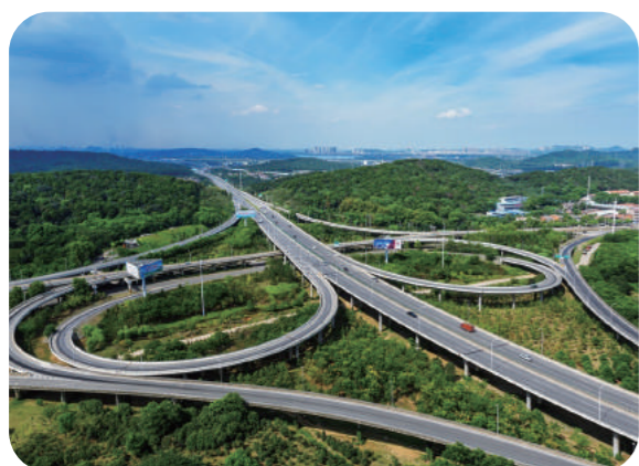
四川高速公路立交桥
