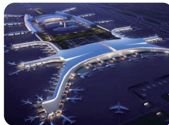
广州白云机场T2航站楼
